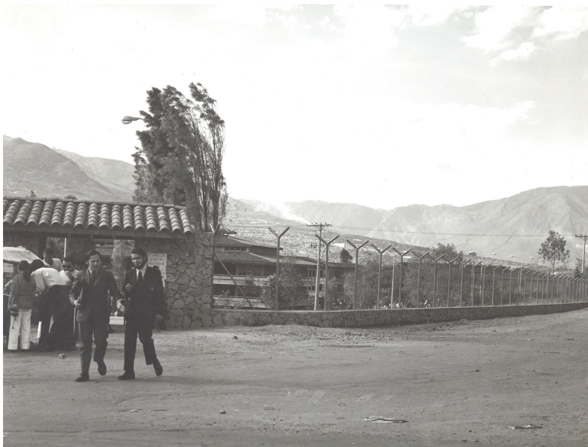
Foto Diego García -DIGAR-. Portería sobre calle Barranquilla. Universidad de Antioquia. 1977. Archivo MUUA.
