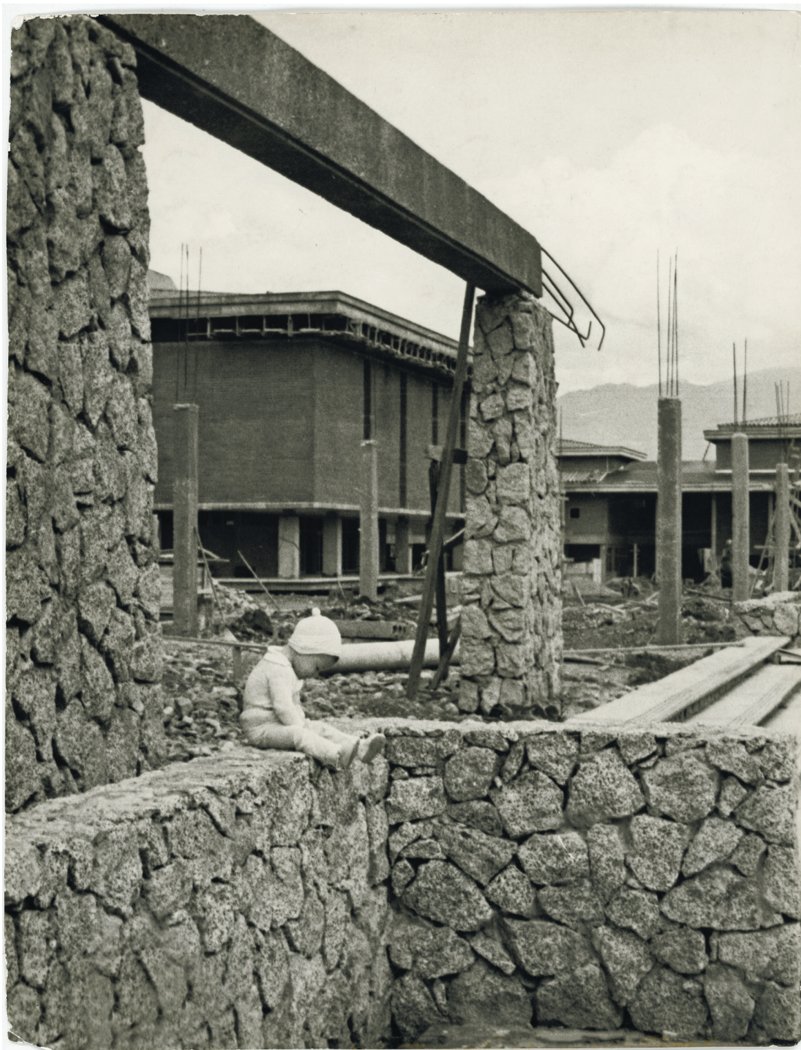
Foto Diego García -DIGAR-. Construcción de la Plazoleta Central (conocida hoy como Plazoleta Barrientos). Universidad de Antioquia. 1969. Archivo MUUA.
