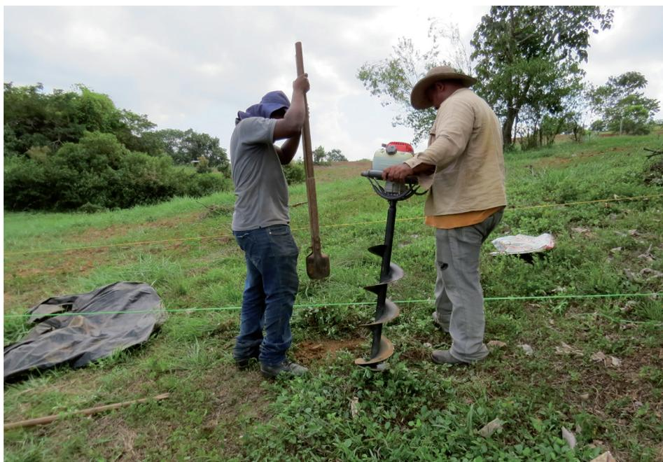
**Imagen 1.** Medición y perforación de hoyos para instalación de los parales
