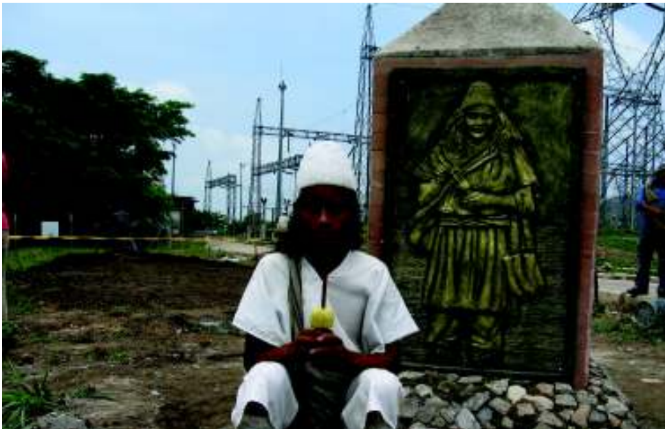
Figura 10. Monumento levantado por los arhuacos en la subestación El Copey
