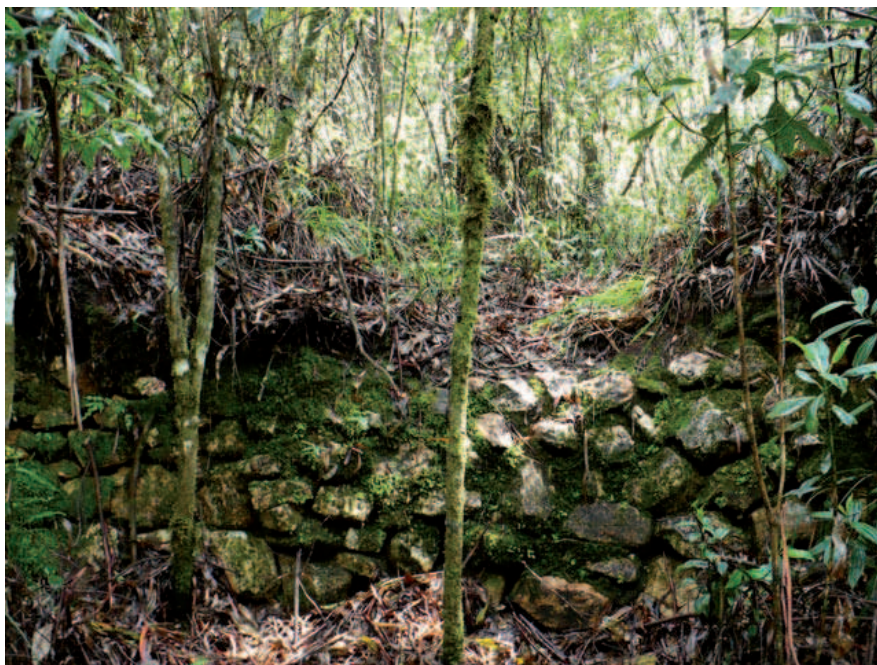
Foto 5. Huerta El Carmelo, muro en el perímetro de la parte baja
