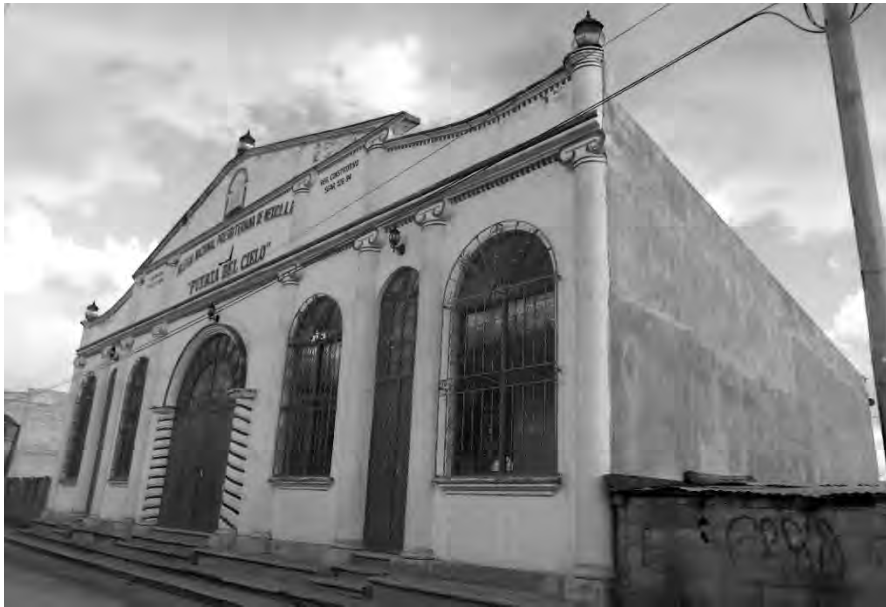
Figura 5 Fachada del templo de la Iglesia Nacional Presbiteriana de México Puerta del Cielo. San Cristóbal de Las Casas, Chiapas. 11 de octubre de 2013
