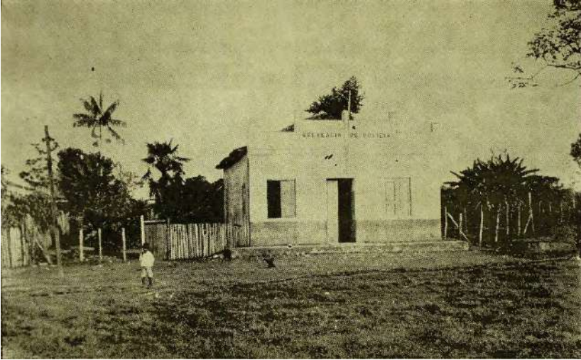
Figura 13 Reparaciones realizadas en el edificio de la Comisaría y Cadena Pública en la actual administración
