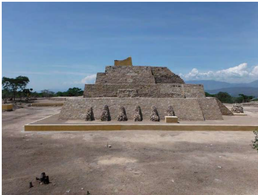
Figura 20 Lado norte del Templo Mayor luego de la finalización de los trabajos de excavación y consolidación de la escultura, 2015
