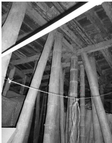
Figura 1. Refuerzo artesanal de la estructura.
