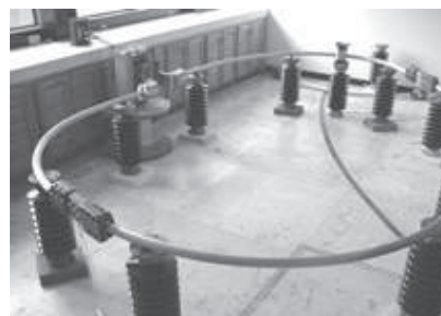
Figura 2 Circuito en anillo para pruebas eléctricas y térmicas de conectores
