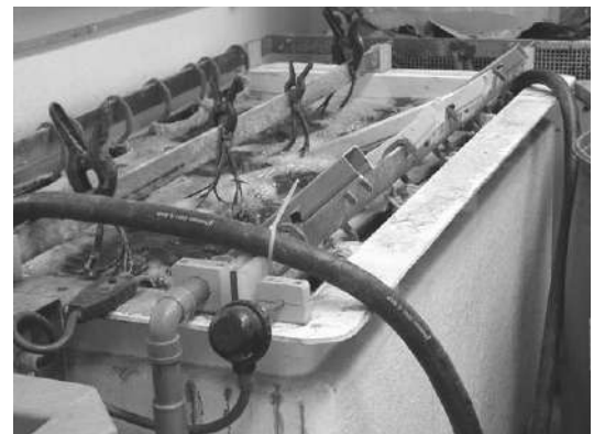
Figura 5 Baño de níquel sulfatado
