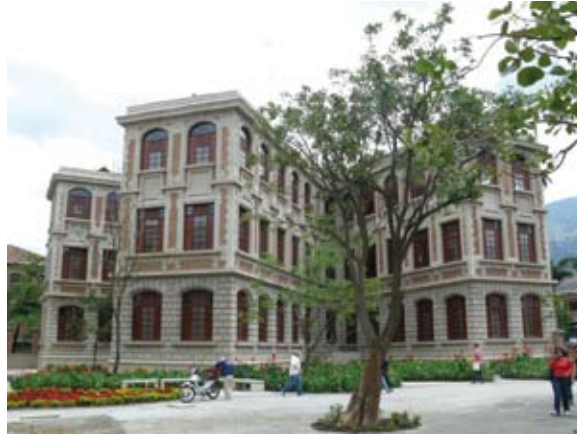
Bloque de Bioquímica de la antigua Escuela de Medicina de la Universidad de Antioquia
