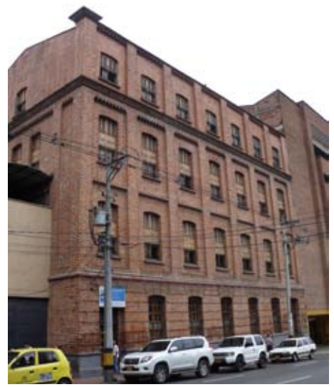
Edificio de la antigua Harinera de Antioquia, calle Pichincha con carrera 56
