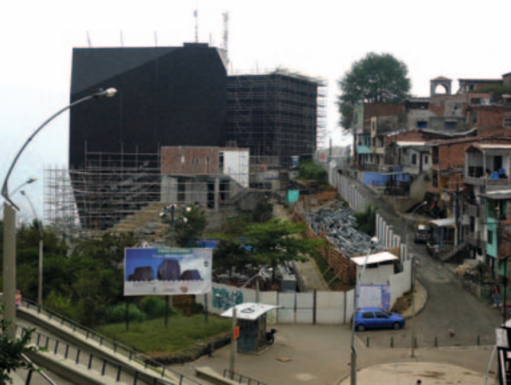
Proceso de desmonte de la estructura de la Biblioteca España en el barrio Santo Domingo, después de diagnosticarle sus fallas y de definir la necesidad de volver a construirla.
