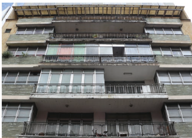
Edificio Puerta Santamaría en la carrera Sucre. Siete pisos. Fachada en la que se destaca el mármol del zócalo y la piedra arenisca.
