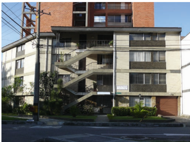
Edificio en la “Avenida Naranjal”, esquina de la Avenida Bolivariana con la carrera 65, construido en la década de 1950. Ejemplo de los edificios de renta, de cuatro pisos. Ya demolido.
