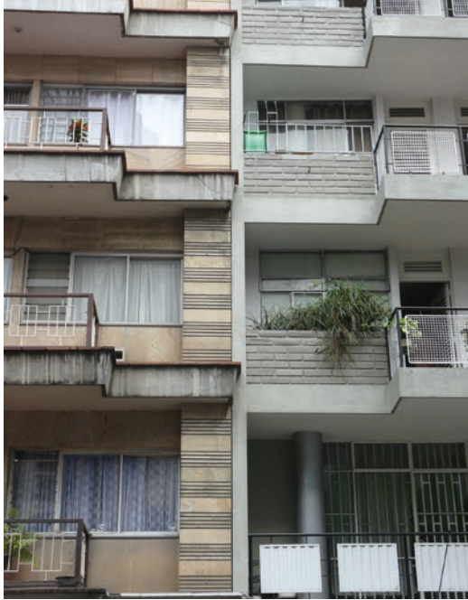
Detalle de los edificios Vélez –a la izquierda- y el Londoño Vélez –a la derecha-, con igual número de pisos y características formales similares. Se diferencian por la materialidad de la fachada y el tipo de trabajo de carpintería metálica.
