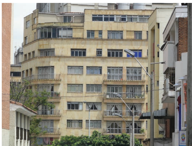
Edificio Caldas, ubicado en la antigua carrera Caldas con la calle Colombia. Diseñado por el arquitecto austriaco Federico Blodek a finales de los años 1940. Edificio de nueve pisos que combinaba locales comerciales en el primer piso con apartamentos.
