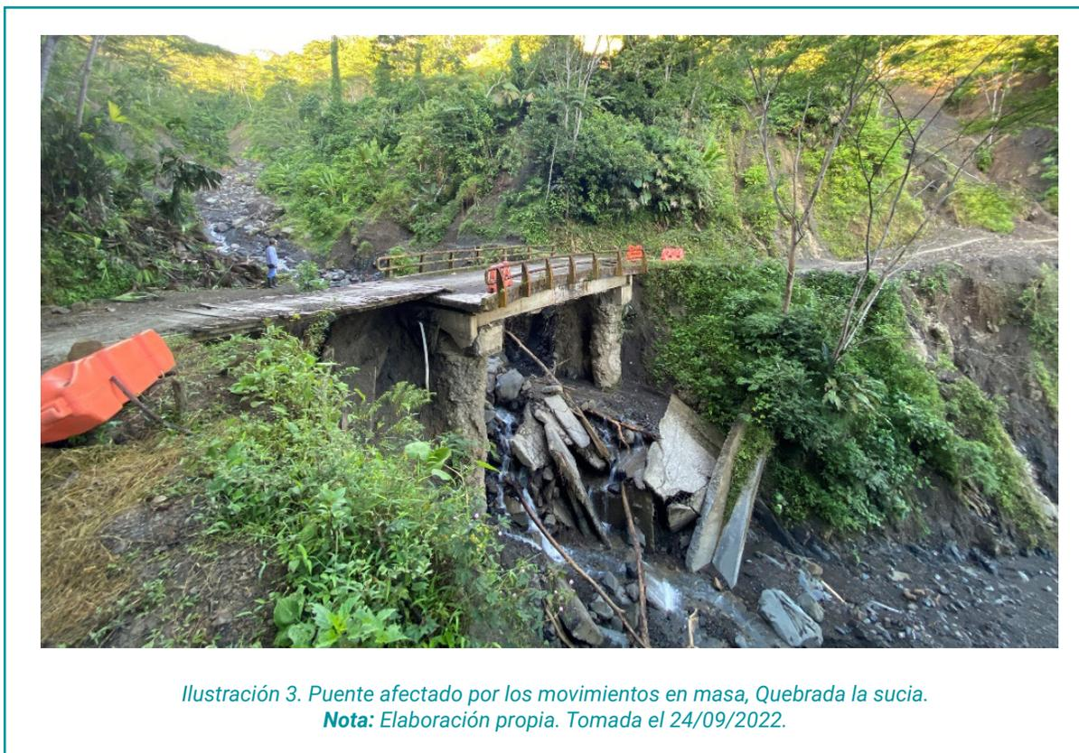
Ilustración 3. Puente afectado por los movimientos en masa, Quebrada la sucia.
