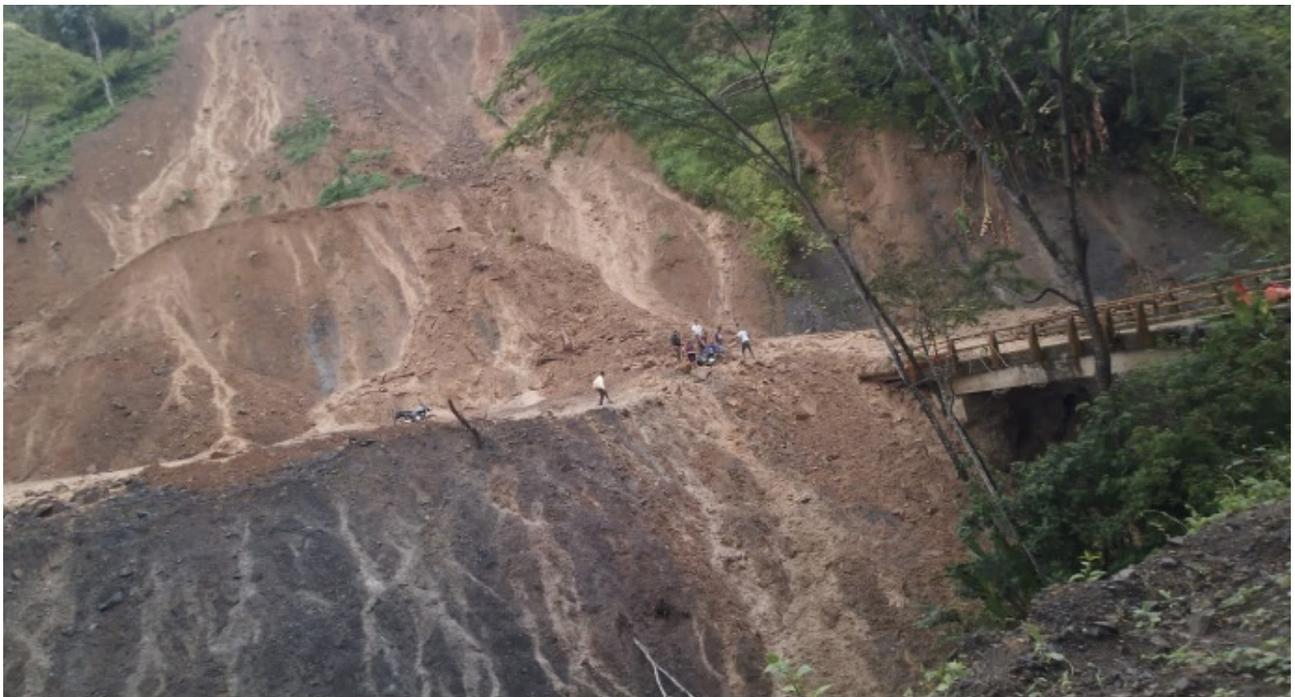
*Ilustración 5. Deslizamiento presentado por lluvia, Quebrada la sucia
